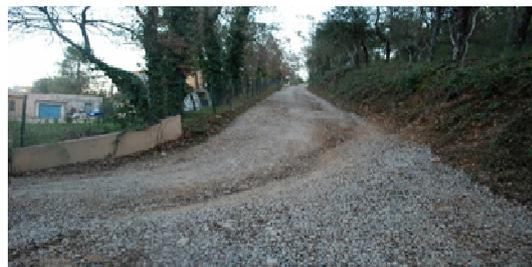
Dans la partie de sa jonction avec la servitude d'accès à la route départementale 561, virage en côte à 90°, et après environ six mois d'exploitation, nous avons pu constater que les véhicules avaient partiellement détérioré l'enrobé.
